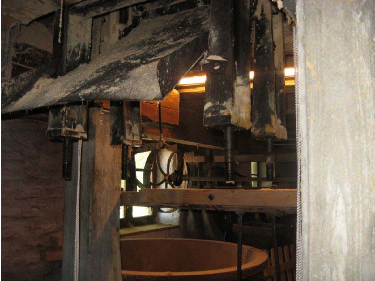
Abb. 6: Rahmen ohne Welle und Lagerböcke
